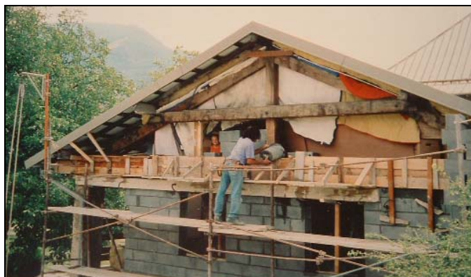
Aan het einde van het 1 e seizoen werd een nieuwe buitenmuur gebouwd.
